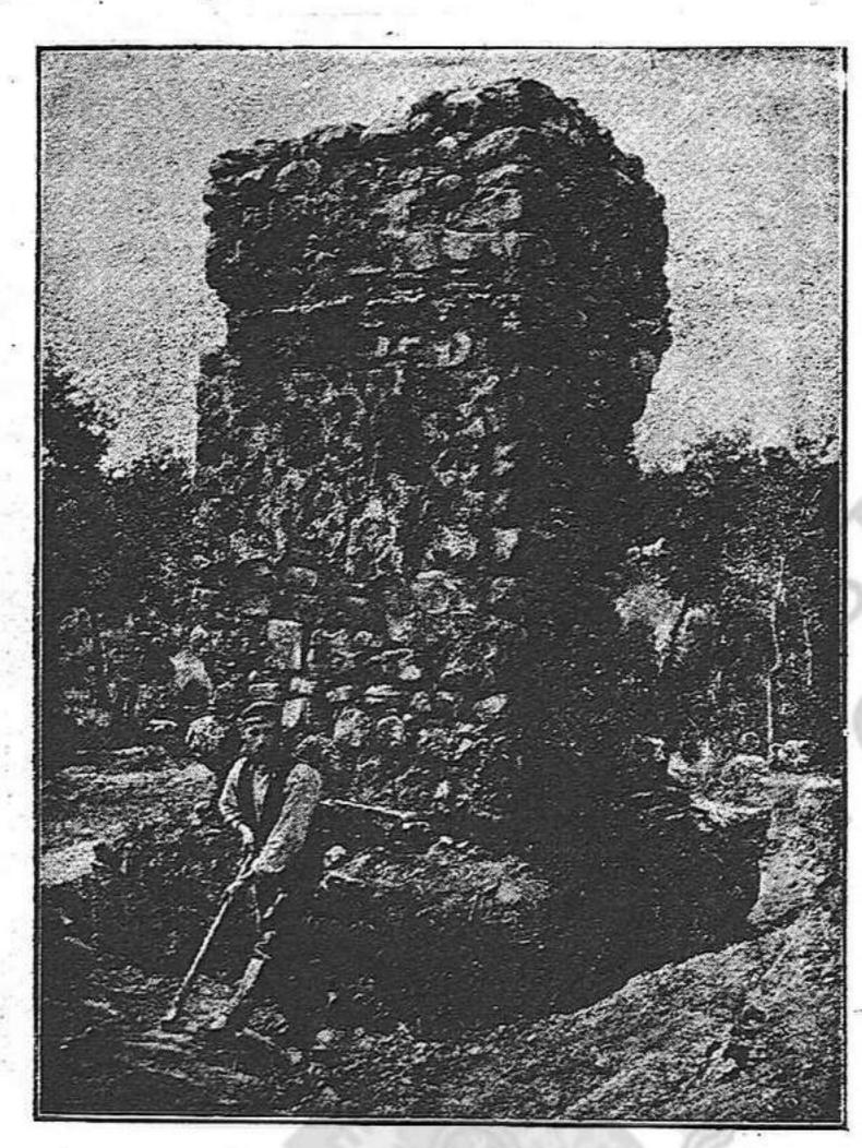
El zócalo, macizo, es proximamente cuadrado (digo préximamente porque entre sus lados se observa alguna pequeña diferencia). y tiene de lado 2 metros, 80 centimetros. Su altura, sobre el nivel de los fundamentos, es de 60 centimetros. Encima y alrededor de él corria un adorno de tejas, cuyo reborde o escuadra ocupaba la parte más saliente; de modo que, siendo tres las hileras de tejas sobrepuestas y reentrando cada hilera de
